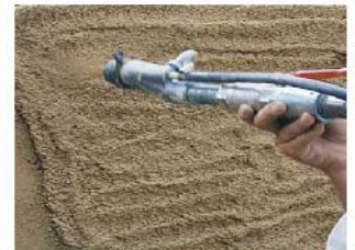
预拌砂浆喷涂
