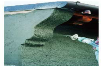
现场搅拌砂浆喷涂
