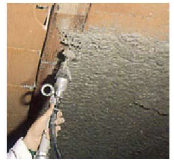
抹灰砂浆喷涂
