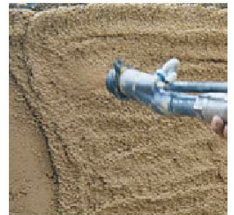
预拌砂浆喷涂
